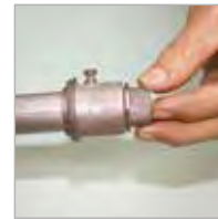
Slide the joint sealing for conduit until it covers the connector. Deslizar la junta de vedación para el electroducto hasta cubrir el conector.
